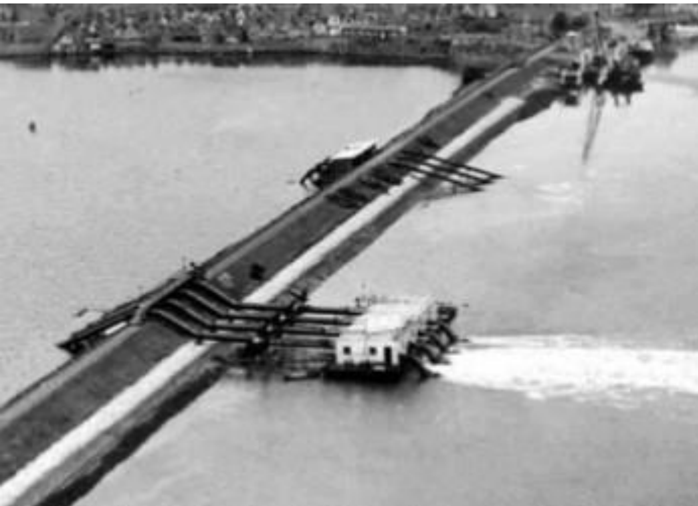
Foto's van het leegpompen van de polder Schouwen van eind augustus tot eind december.
